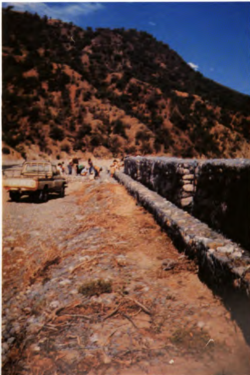
La defensa después de la riada. Nótese la deformación de la colchoneta
