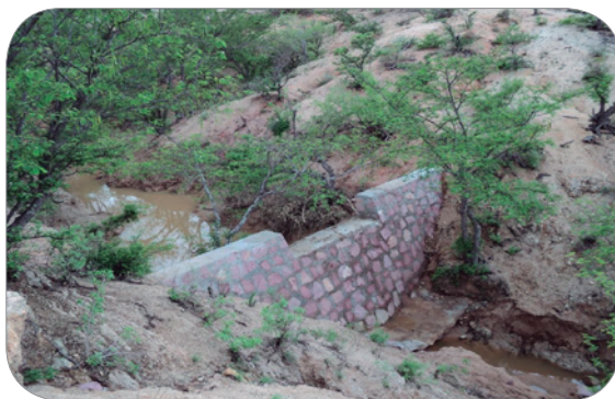
Figura 17a. Diques de almacenamiento de agua
