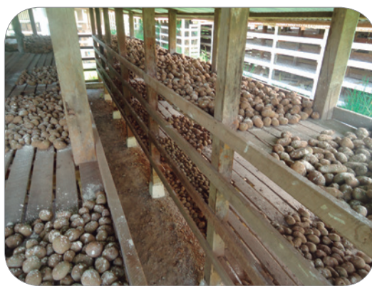
Figura 32. Exterior e interior de una estructura rústica para el almacenamiento de tubérculos-semilla de papa en Intibucá.
