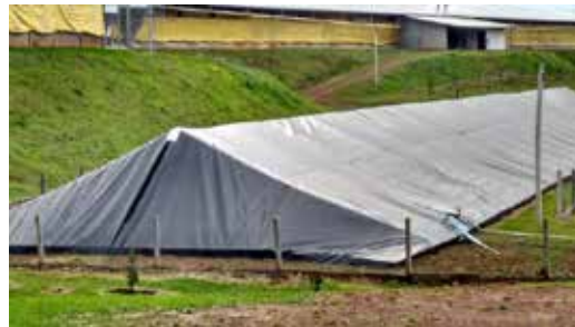
FOTO 05 | Cisterna em funcionamento.
