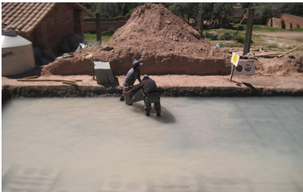
Figura 5: Fraguado de losas de concreto para CM.
