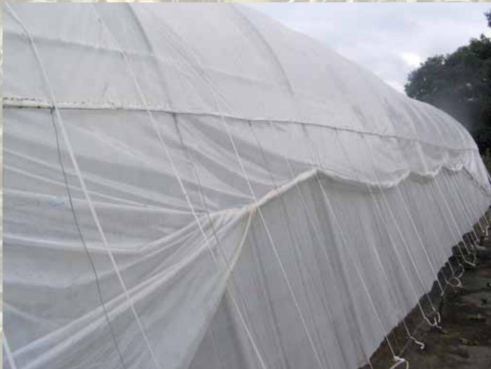
Figura 5: Ventilación lateral de un invernadero.
