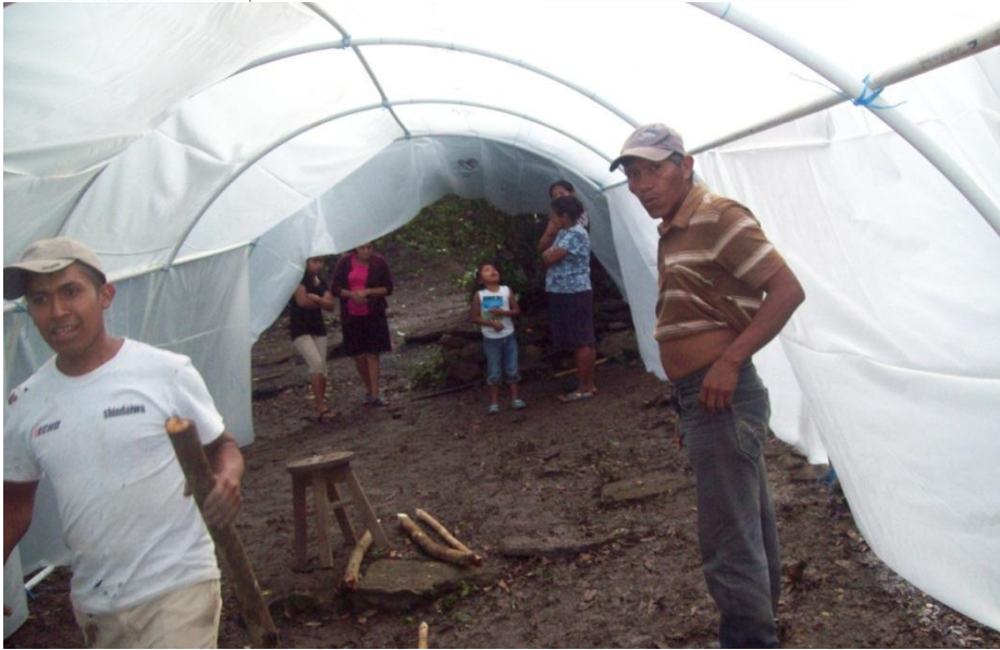
Instalación de microtúnel en la Cooperativa . La Pita- Comunidad Ocalca
