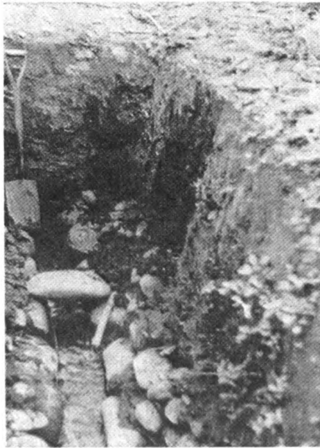
Fig. 6.3 —Algunas de las mejoras de la finca se realizan con mano de obra y materiales de la misma. Una zanja de drenaje cubierta. Valle de Huara, Perú. (Foto: Oficina Técnica de Agricultura, Lima).
