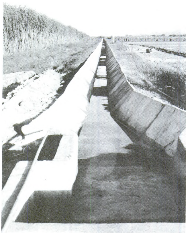
Canal revestido com placas de concreto. Observe-se detalhe da caixa de distribuição
