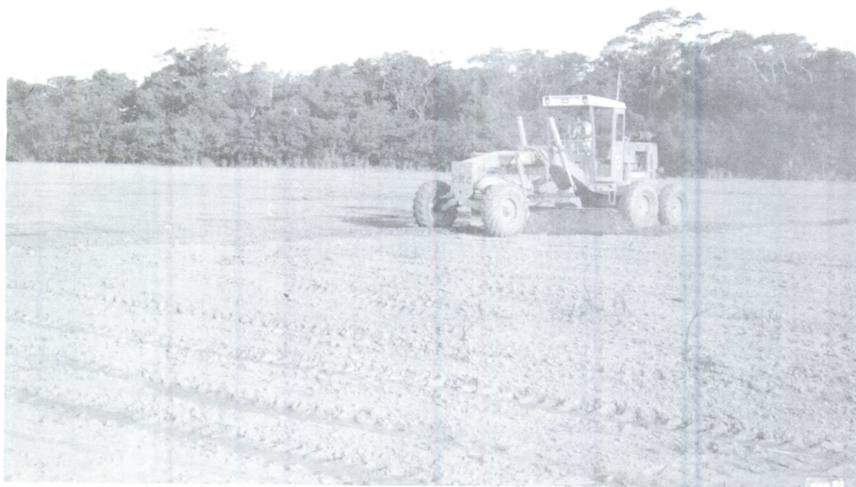
Sistematização da área com patrol, para regularização das curvas de nível
