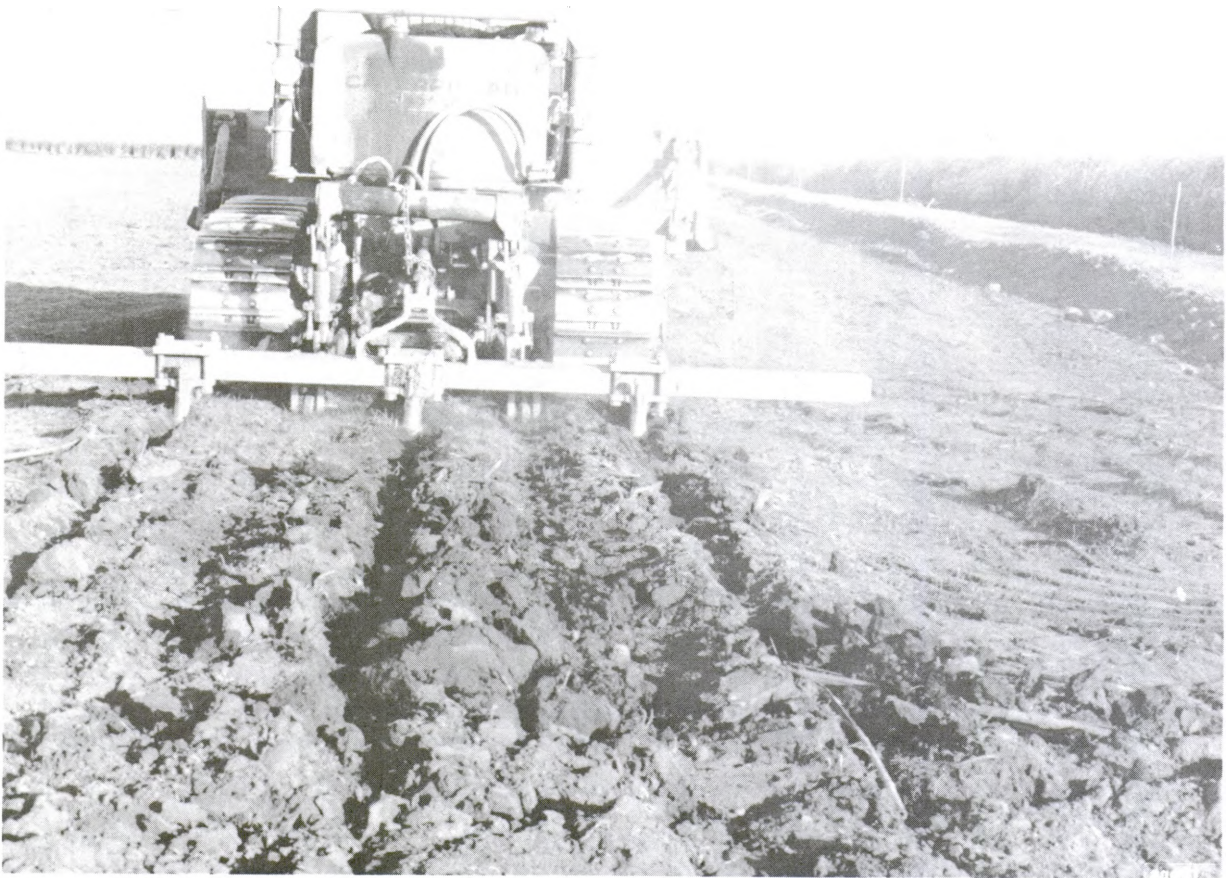
Primeira passagem de subsolador de 3 pontas a 0,60 m de profundidade. Trator Cat. D-6
