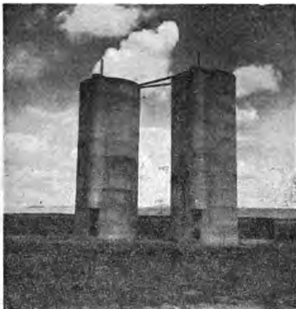
(Fig. 97) Silos torre en la Hacienda San Antonio cerca de Chuquibambilla.
