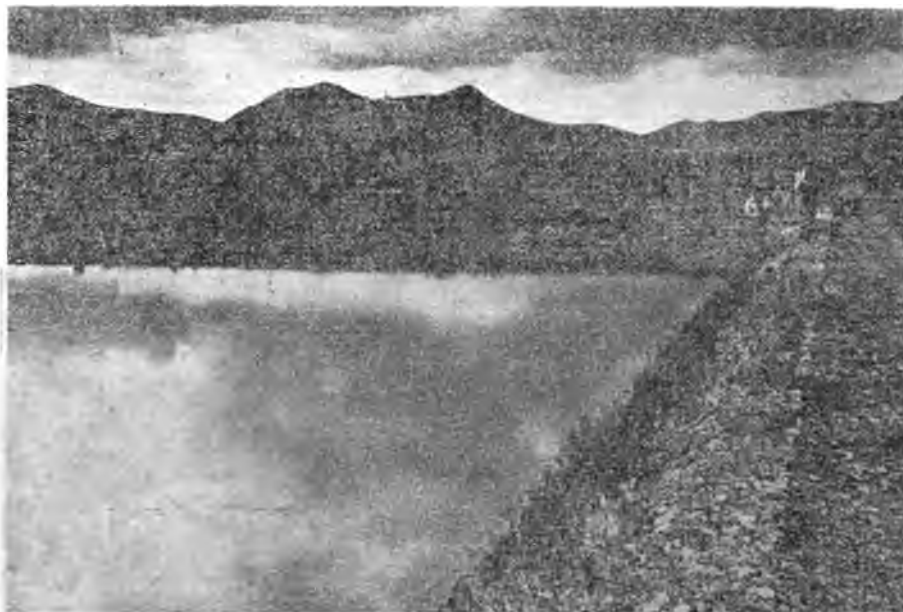
(Fig 95) Reservorio de agua, extraída del subsuelo, Patacayama.
