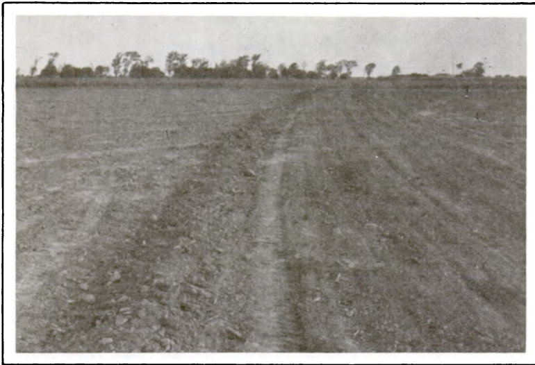
Esta fotografia mostra, à direita, o campo após a segunda passada, e à esquerda, após uma terceira laminada com motoniveladora.
