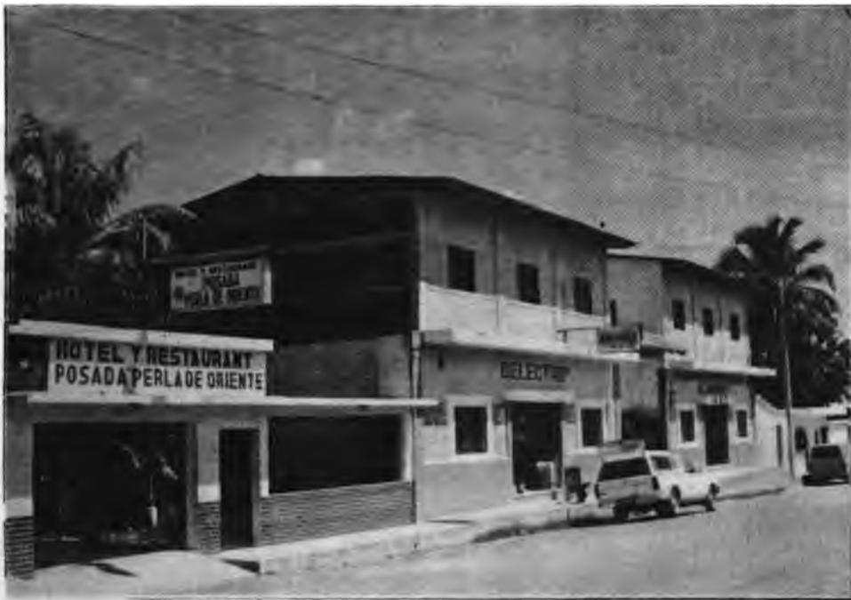
F-9: Construcción de albañilería de ladrillo. Note las columnas y vigas de refuerzo. Las construcciones con bloques de concreto tienen un refuerzo similar.
