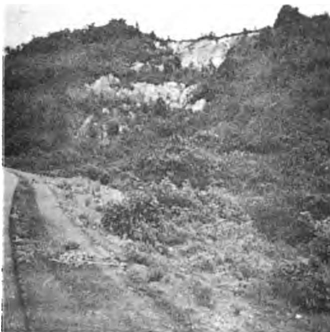
**F-22:** Derrumbe en la carretera Nueva Ocotepeque La Labor que ha provocado la inestabilidad de unos 50 m. de carretera. Esto obligó al cambio de trazo.
