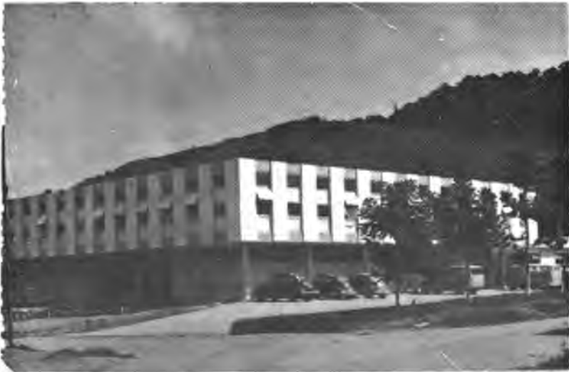
Fig. 2.—Edificio del Instituto de Economía.
