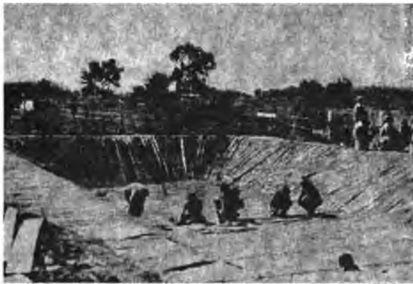
Fig. 7. a).- Colocación y amarre de mallas de refuerzo. b).- Colocación del mortero cemento-arena
