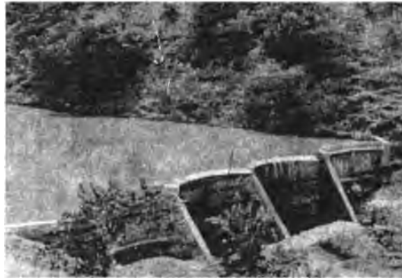
Fig. 4. Micropresa llena en San Pablo Huitzo, con altura de 5 m. Observe aguas abajo la cortina de mampostería que se venía construyendo 4 años antes.
