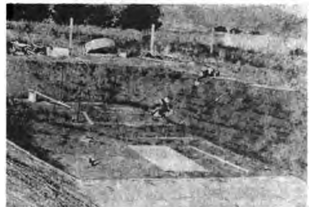
Fig. 7. a).- Colocación y amarre de mallas de refuerzo. b).- Colocación del mortero cemento-arena
