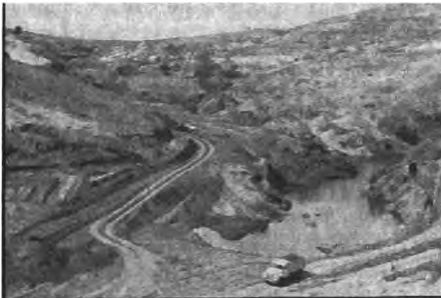
Figura 2. Avances del proceso constructivo del bordo de almacenamiento "La Ciénega" en Tulancingo, Oax.
