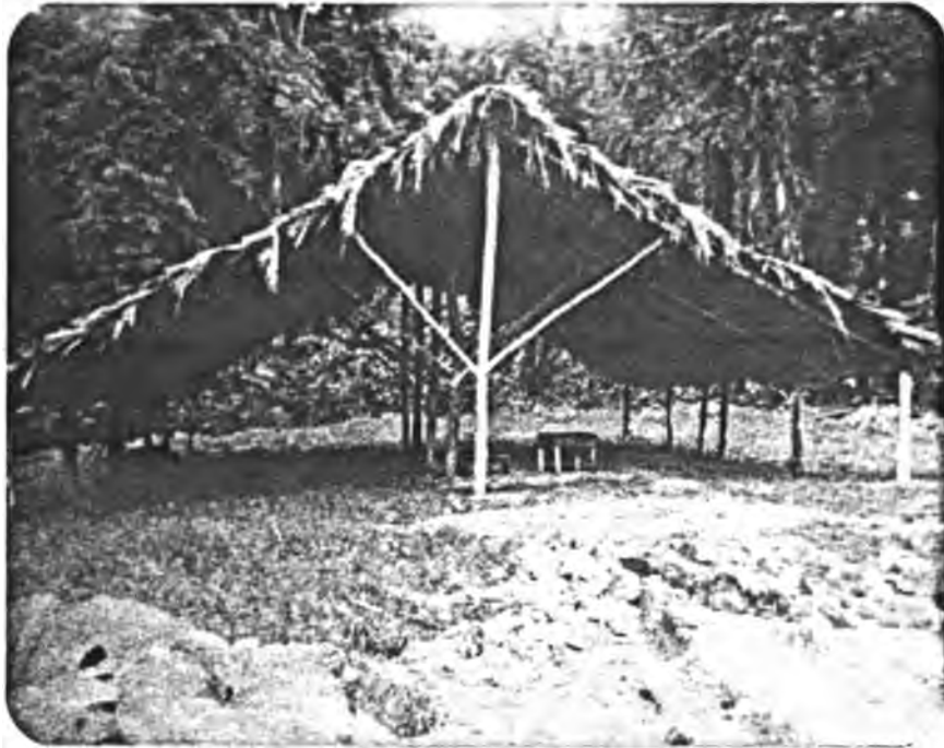
Construcción rústica típica de la zona, la cual podría tomarse como modelo para galera de ordeño.
