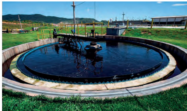
Estação de Tratamento em Seropédica/RJ
