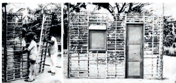
Taipa pré-fabricada, década de 1960. Jaboatão dos Guararapes – PE Conjunto Cajueiro Seco / Acácio Gil Borsó
