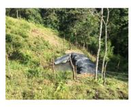
Las innovaciones en el manejo hídrico, con la construcción de un microreservorio a cielo abierto con geomembrana, aumentan la disponibilidad y el acceso al agua en la finca, reduciendo así costos de transporte de agua desde lugares más lejanos.
