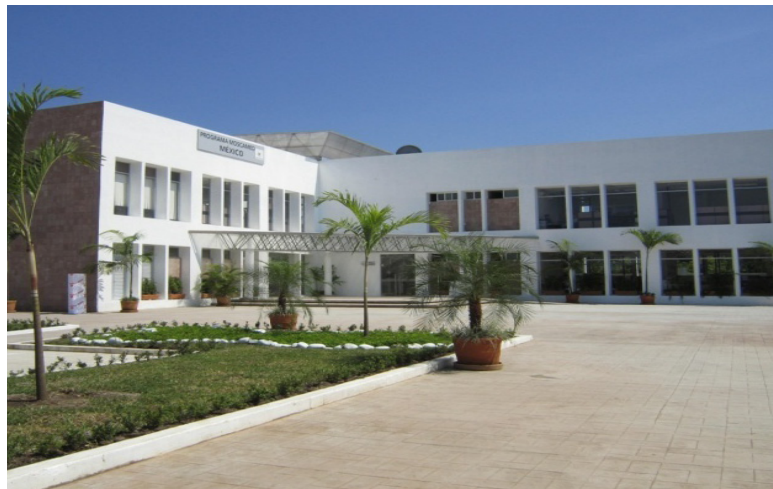
Figura 3. Nuevo Edificio Administrativo del Programa Moscamed México. El Carmen, Cantón Leoncillos, Municipio de Tapachula, Chis.
