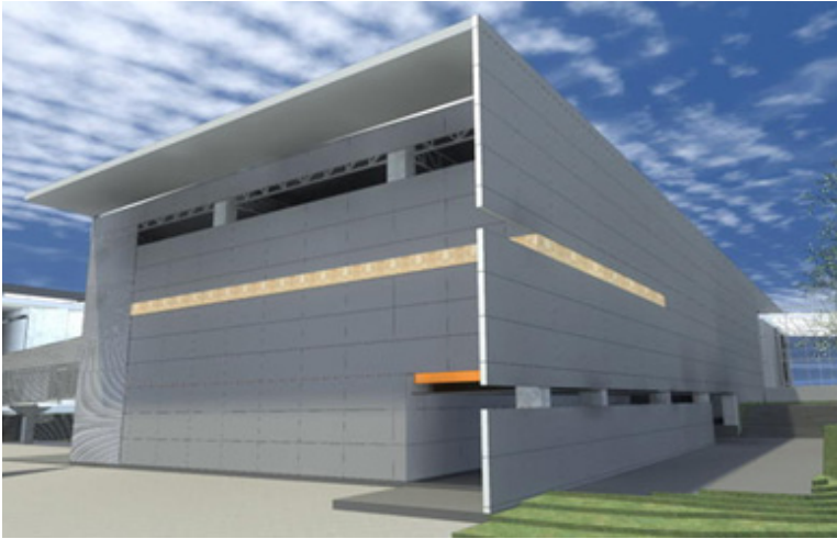
Figura 21. Proyecto de construcción de la nueva Planta Moscamed.
