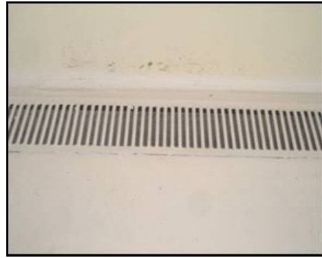
Ilustración 14 Desagüe con rejilla
