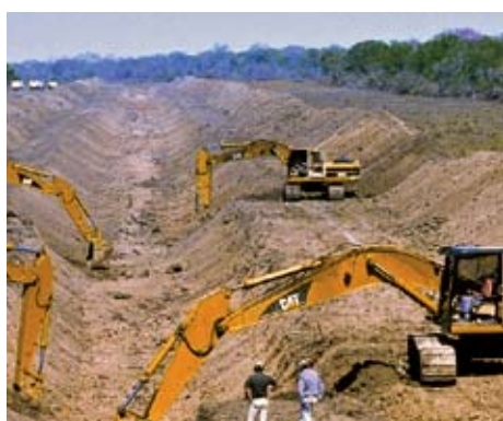
PROSAP – CONSTRUCCIÓN DE CANALES
