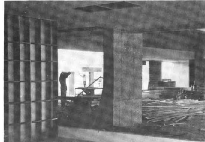
Se inicia la obra de acabado de paredes.
