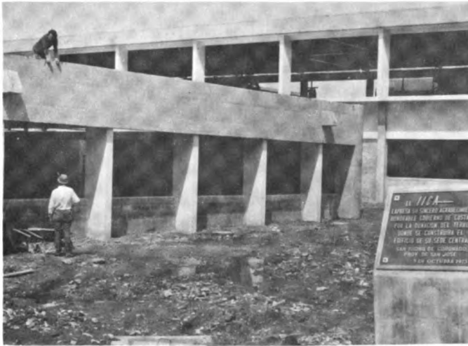
Se levantan las columnas.
