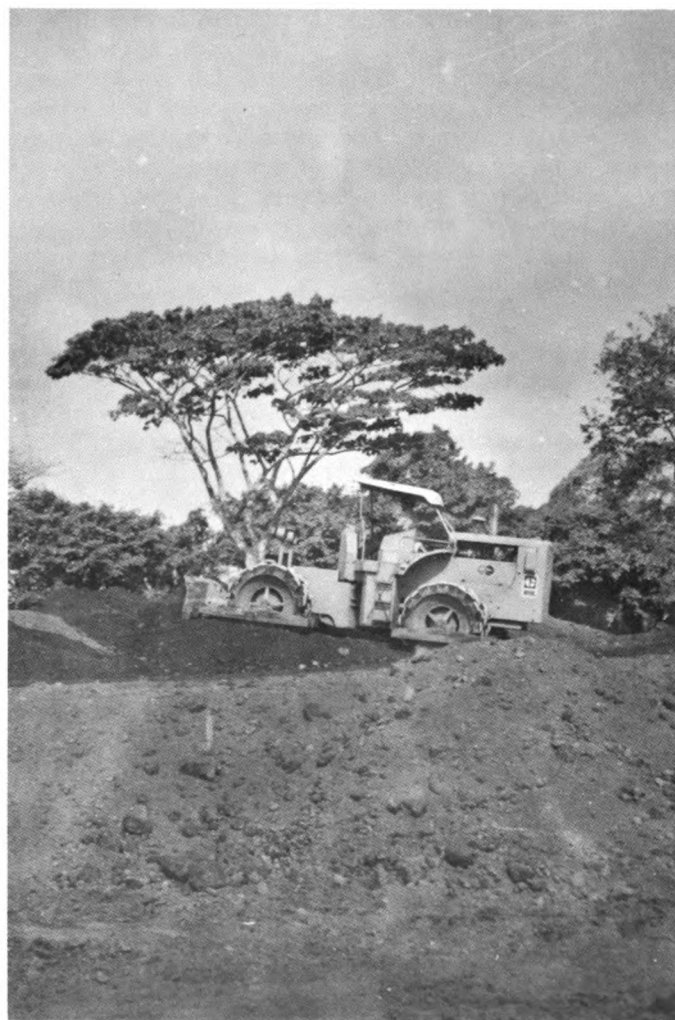
Empieza la obra, abril de 1974.
