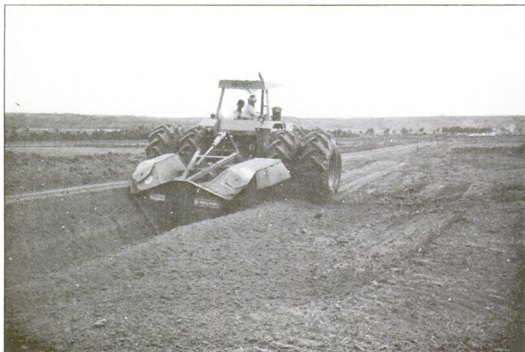
A valetadeira regulada para construção dos canais, observa-se o material que esta saindo do corte e depositado ao lado para conformar a borda do canal.
