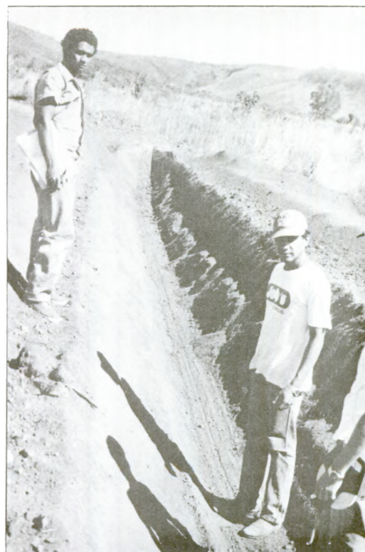
Inspeção e medição das seções transversais dos canais e drenos feitas pelos técnicos do Colégio.
