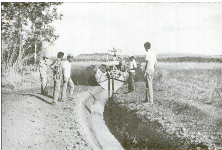
Construção de um dreno principal com água.
