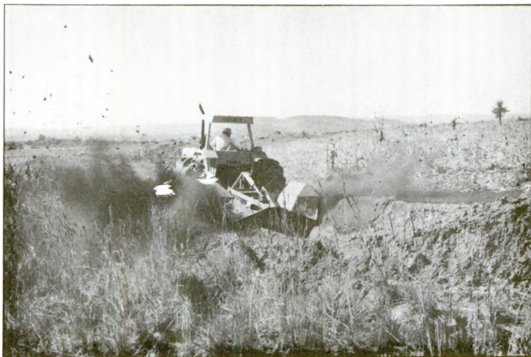
Construção de drenos úmidos em terreno úmido e firme.
