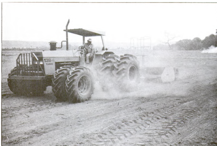
Momentos do acabamento no nivelamento em tabuleiros.
