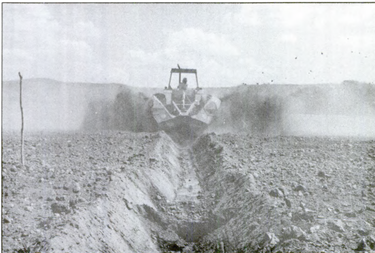
Execução de um dos canais irrigantes usando a valetadeira Dondi.
