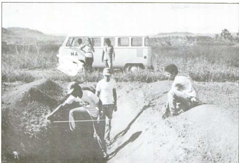
Inspeção e medição das seções transversais dos canais e drenos feitas pelos técnicos do Colégio.
