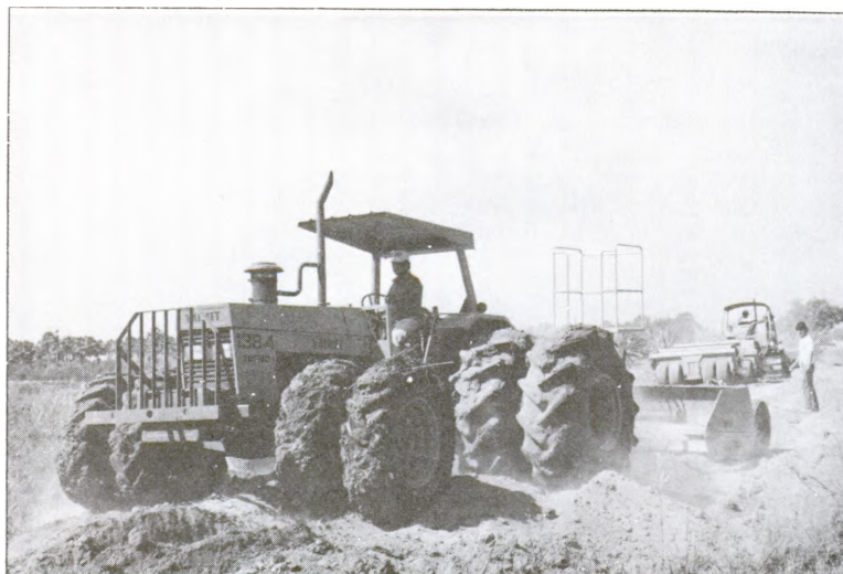
Outro aspecto do mesmo trabalho. O material é distribuído pela caçamba niveladora.
