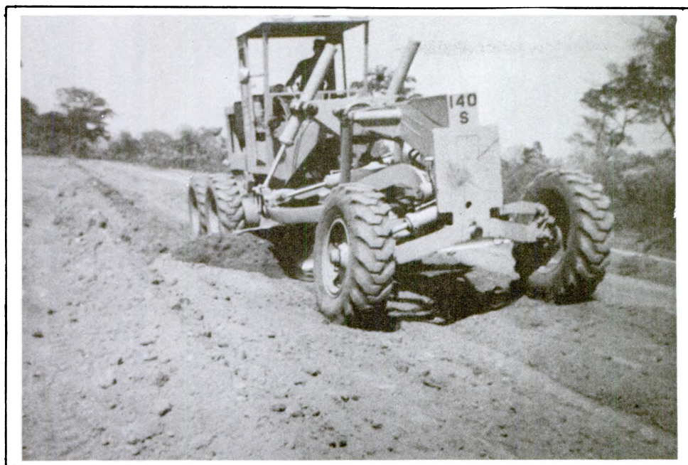
Construção de drenos superficiais. Primeira passada da motoniveladora para construção da plataforma. Depois, com mais duas "passadas" (ida e volta) e com a lâmina inclinada a 22 graus, faz-se a seção transversal triangular.
