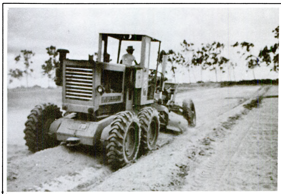
Últimas passadas da motoniveladora para distribuir o material remanescente das "passadas" anteriores, de modo a possibilitar a interligação dos sulcos com o dreno superficial.
