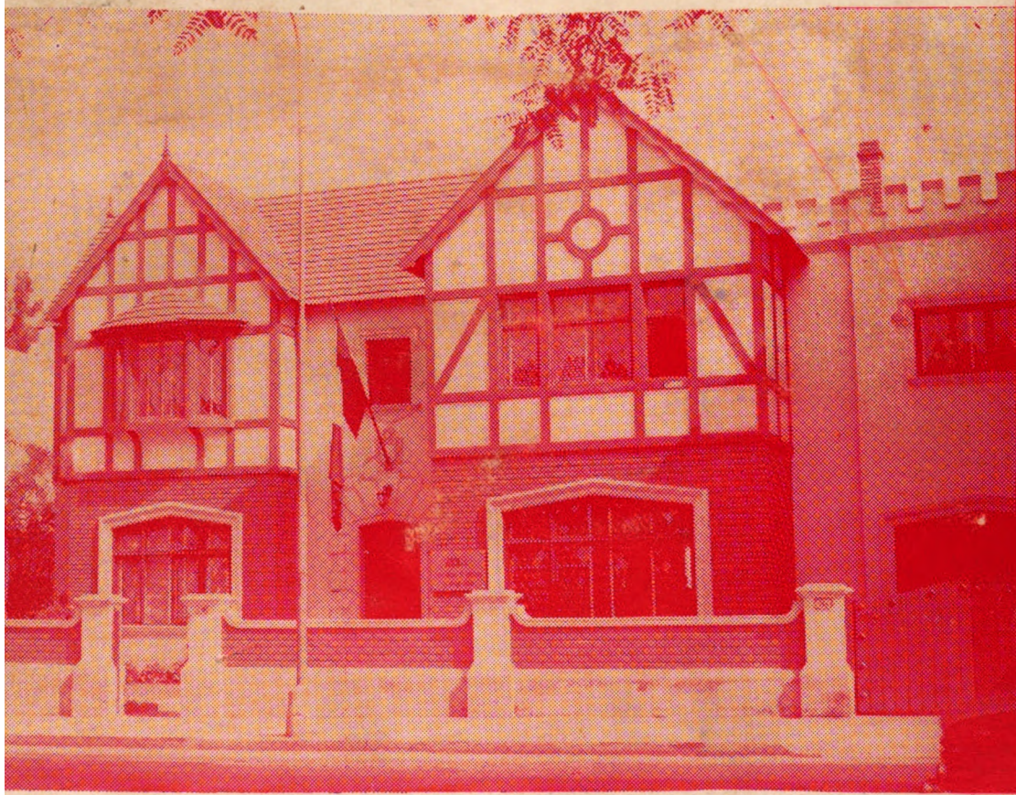
AVENIDA JOSE PARDO 254 MIRAFLORES
