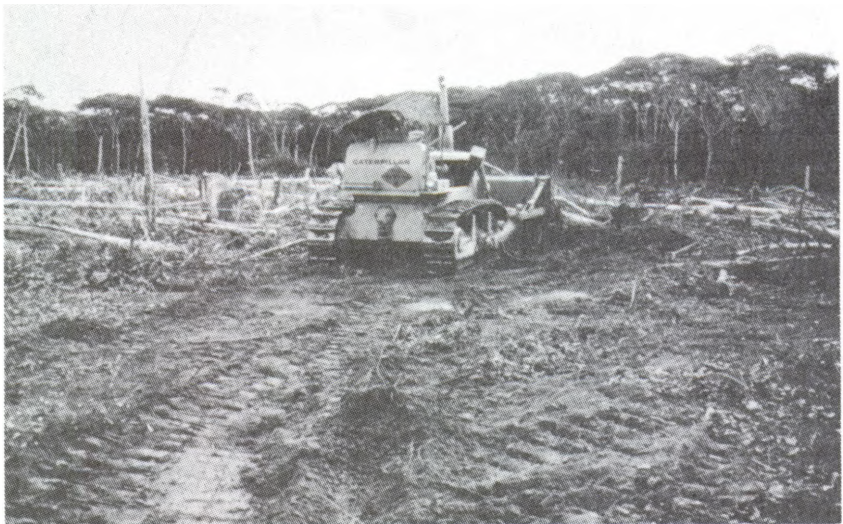
Fig. 10.21. Operaciones mecanizadas de desmonte como las de esta figura en Ultisoles de textura ordinaria producen una compactación severa del suelo y rendimientos más bajos que los que se obtienen con el sistema tradicional de corta y quema.
