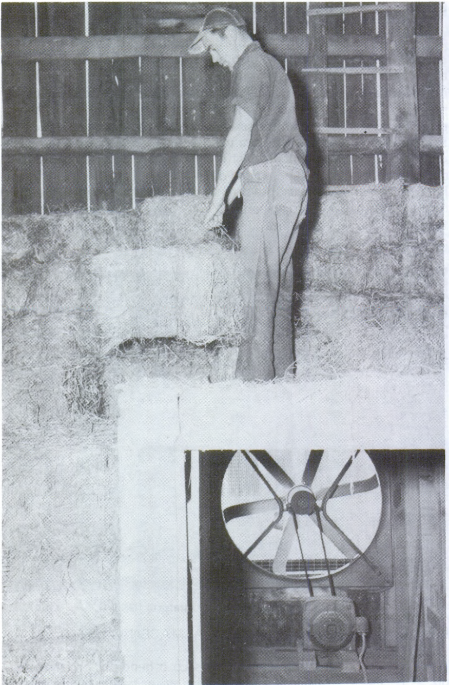
Fig. 93. Granero ventilado para heno en pacas (USDA).
