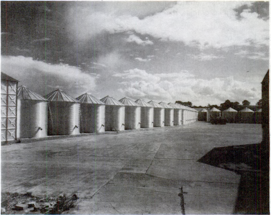
Fig. 110. Silos de aluminio corrugado para almacenar granos, con una capacidad de 15 a 135 toneladas (F. Barby).
