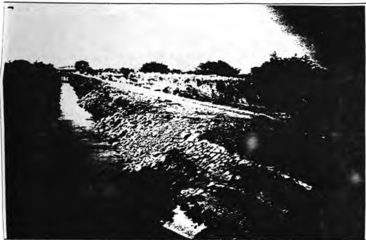
SALIDA REPRESA 1 + 475 REPARADA. Prolongación de Zampeado y depósito de una capa de piedra de río para proteger la tierra contra la erosión.
