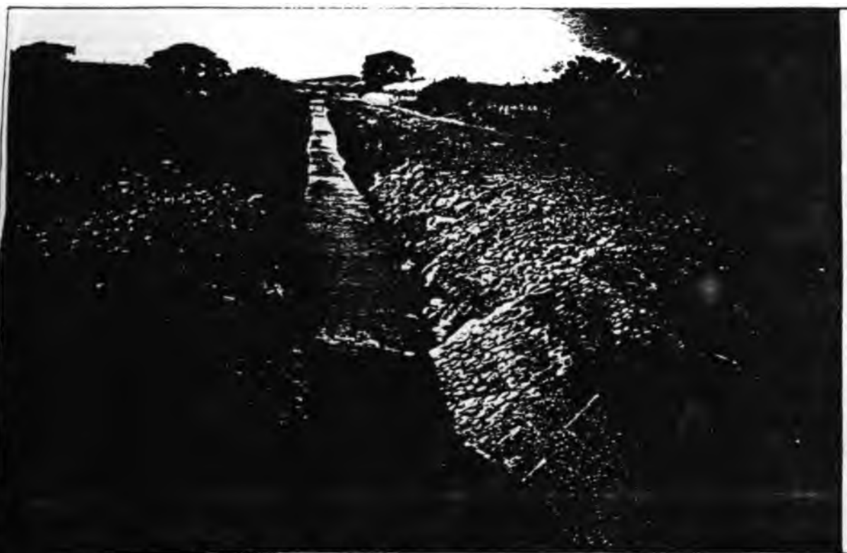
SALIDA REPRESA 1 + 775 . REPARADA. El encauzamiento del canal con Zampeado y piedra suelta de río para proteger las paredes del canal contra la erosión.
