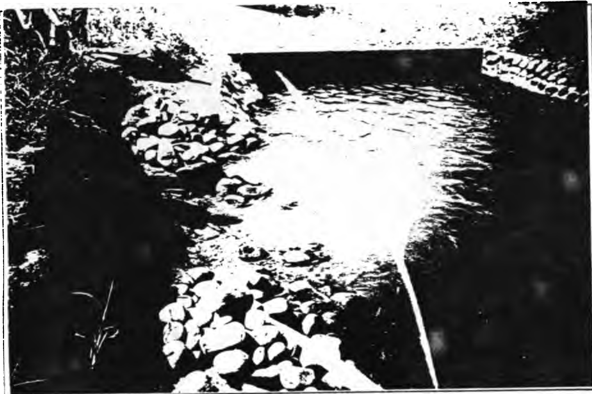
SALIDA DEL PASO 0 + 840. Las obras de arte en los sistemas de riego facilitan la comunicación. La reducción de la sección aumenta la velocidad de salida del flujo que lo hace más erosivo. El zarpeado y el enrocado protegen al talud de la erosión.
