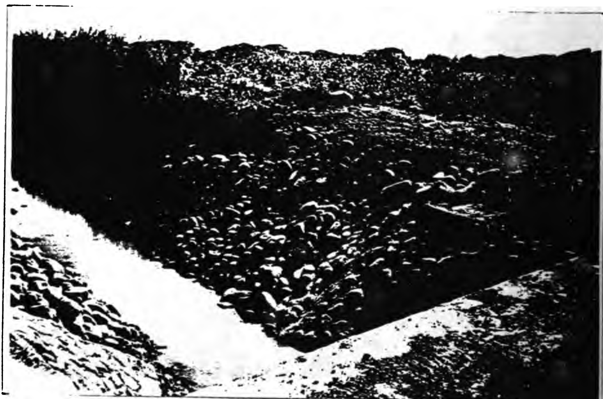
ENTRADA PASO 1 + 790. Encauzamiento del canal mediante Zampeado y depósito de piedras de río. Una forma con fines de protección contra la erosión.
