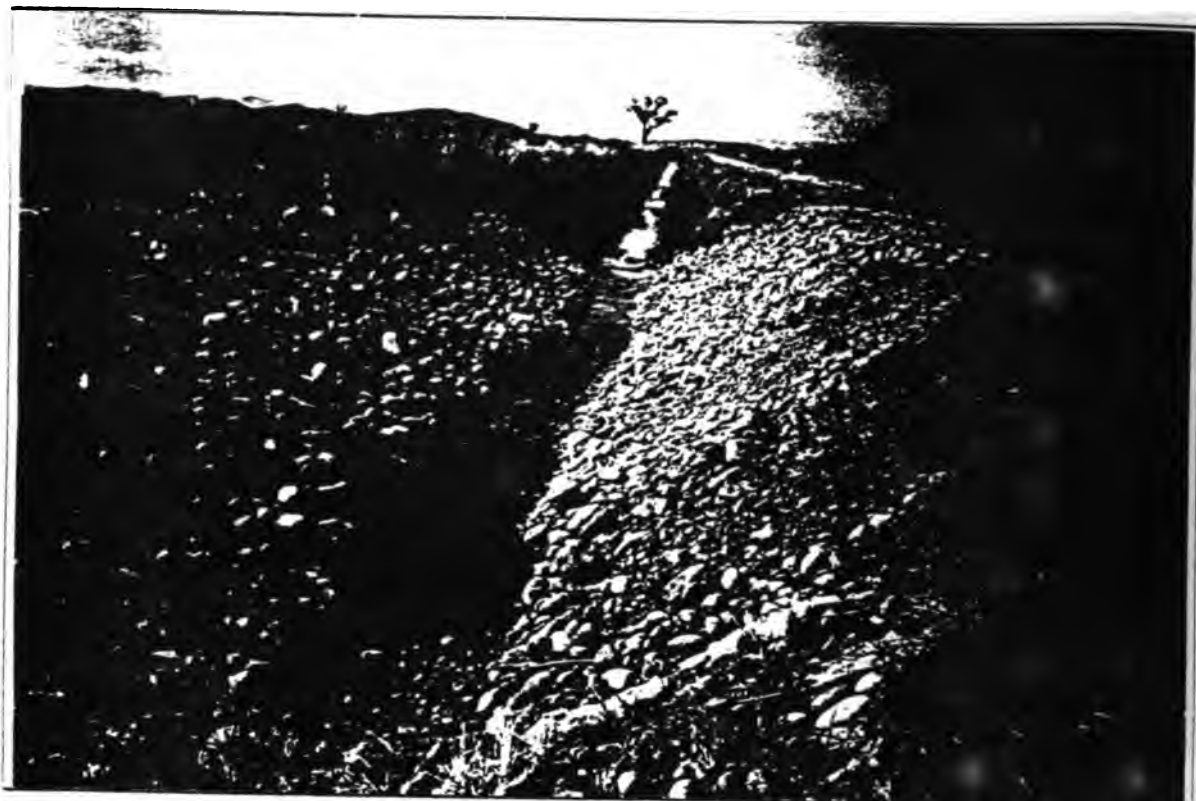
SALIDA PASO 1 + 790. REPARADA. Una vista de detalle de la capa de piedra de río para encauzar el canal y darle la protección contra la erosión del flujo.
