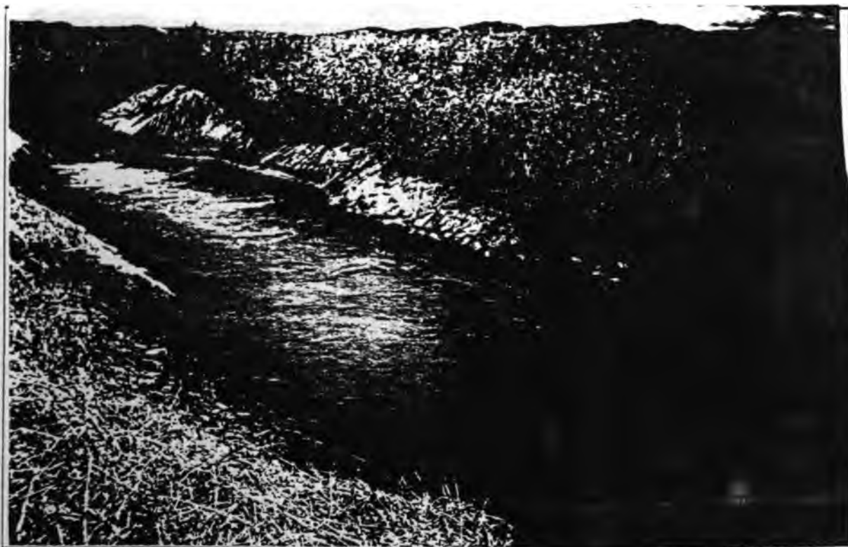
SALIDA CAIDA 4 + 300. El zarpeado debe de prolongarse hasta el punto en que la energía ha sido totalmente disipada.
