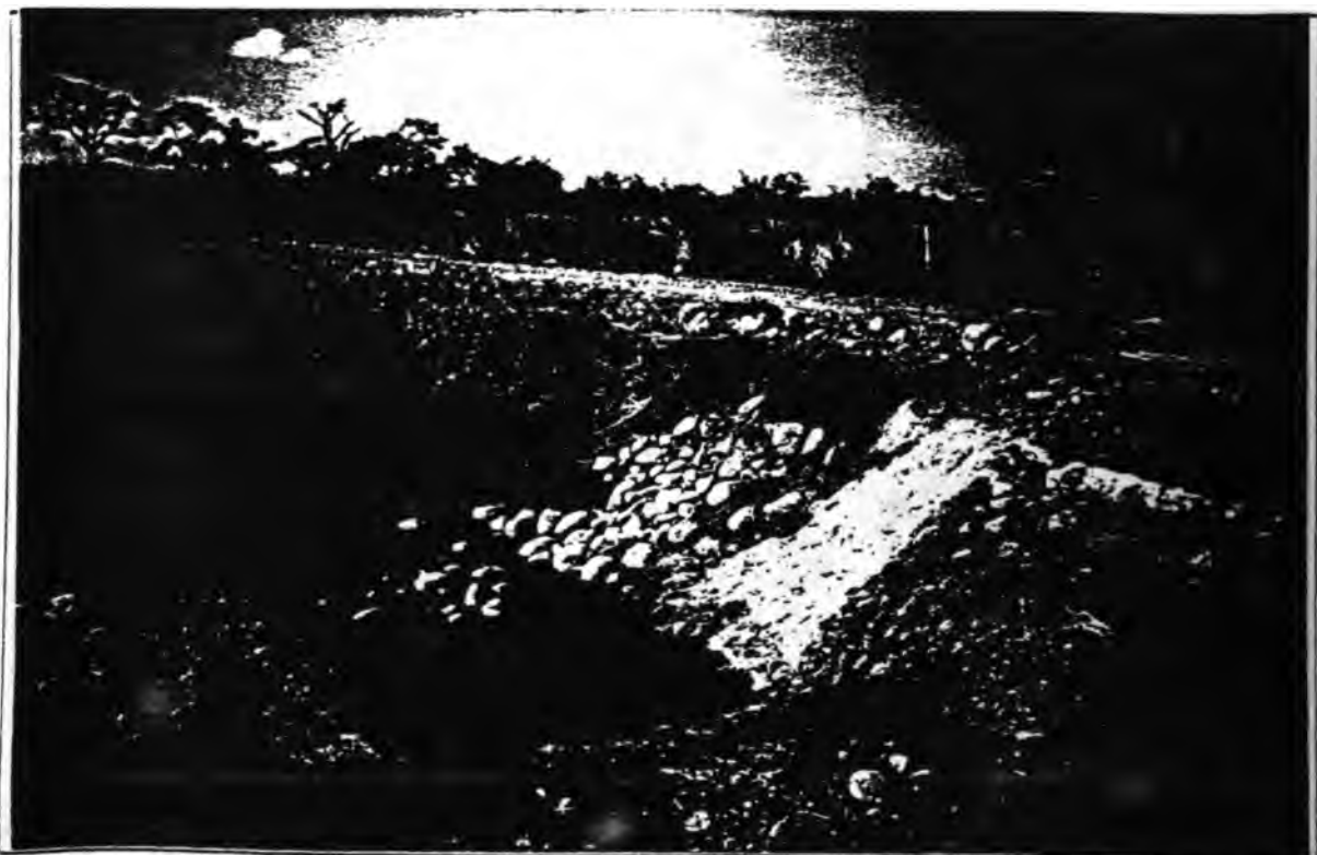
SALIDA PASO 1 + 080 REPARADO. La prolongación del Zampeado y el depósito de material de río empleados como medios de protección de Taludes contra la erosión.
