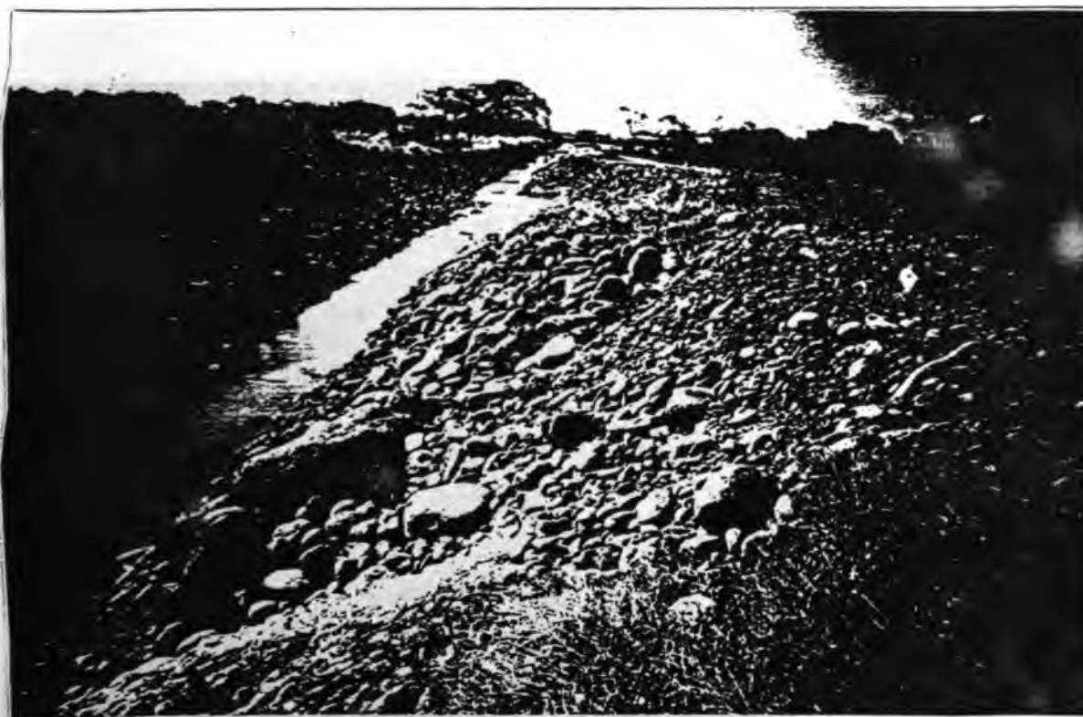
SALIDA CAIDA 0 + 880 REPARADA. Una vista más cerca del material empleado para cubrir la tierra arcillosa natural para protegerla contra la erosión.
