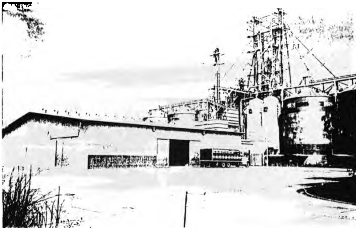
Silos del IMA - Las Barreras, Santiago, Prov. de Veraguas
