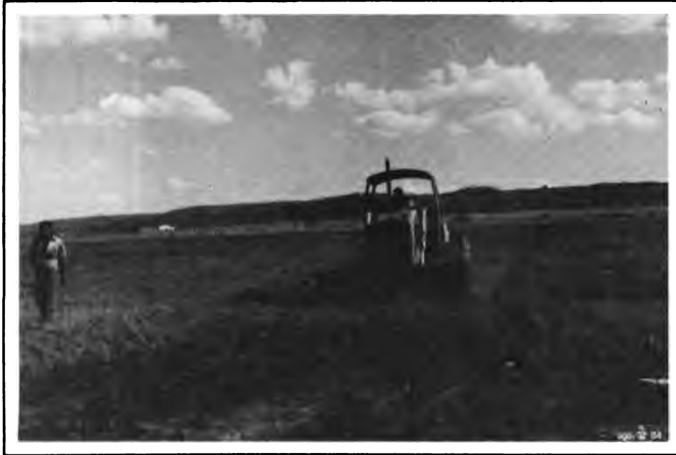
Momento em que a máquina fazia a construção das plataformas com saltos para os canais irrigantes e drenos superficiais que seguem as máximas declividades.
