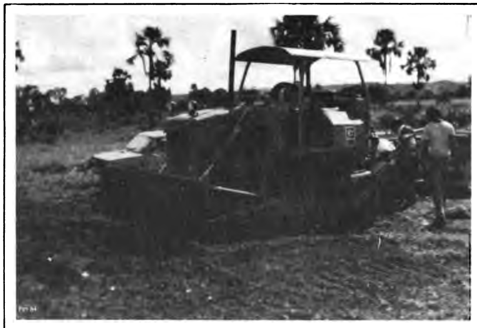
Coleta de material da camada superficial do solo para ser depositado na parte superior da ponte de madeira.
