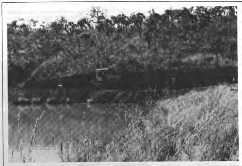
Construção de plataformas para a execução do novo vertedouro.;
