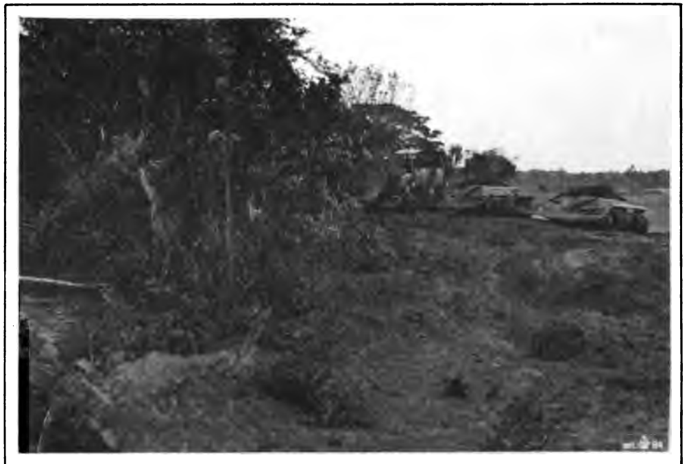
Transporte de material para a construção de diques na barragem nova.
