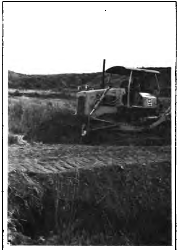
Construção de plataformas sem saltos para execução futura do canal principal.
