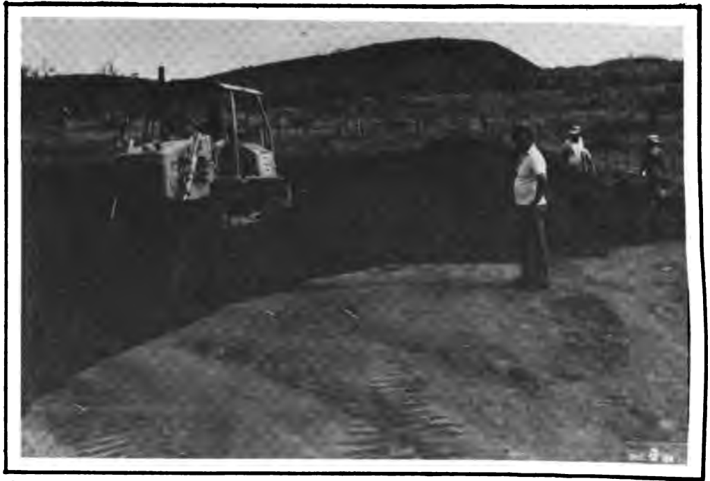
Cortes e aterros para o fechamento do antigo vertedouro na barragem maior.;
