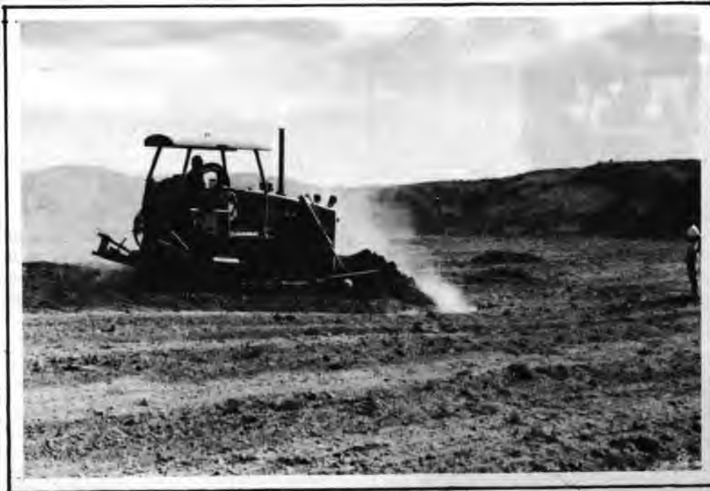
Trabalhos orientados e marcados pela equipe de topografia para a área exata de operação da máquina.
