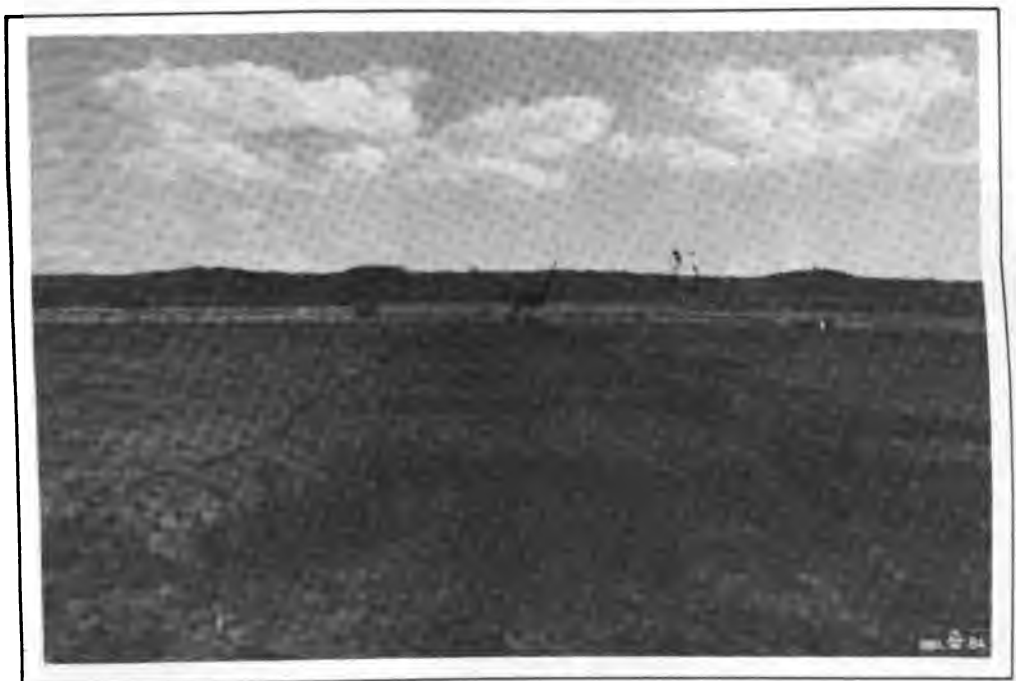
Vista de um trabalho de plataformas pronto para a execução pela valetadeira de canais irrigantes e drenos superficiais.
