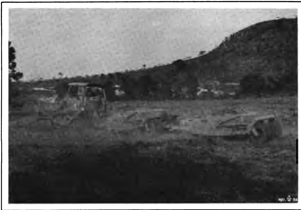
Transporte de material para a construção de dique no Ribeirão Mestre D'Armas.
