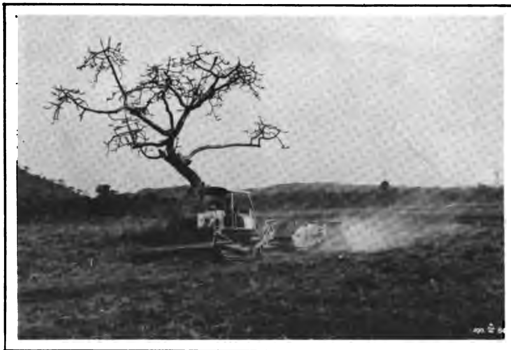
Trator de esteiras desenvolvendo dois trabalhos simultaneamente: cortes nas partes altas para construção de tabuleiros e aproveitamento do material para construção do dique de defesa no Ribeirão Mestre d'Armas.
