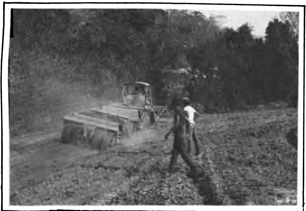
Além do transporte de material, o trator de esteiras Caterpillar D4E faz a compactação e distribuição deste material.
