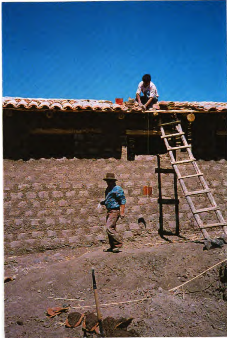
EJECUCION DEL PROYECTO DE RECONSTRUCCION Y DE DESARROLLO
