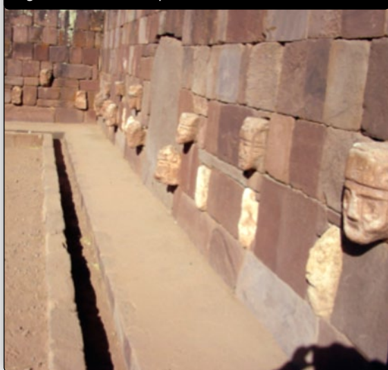
Figura 4. Canal en templo subterráneo
