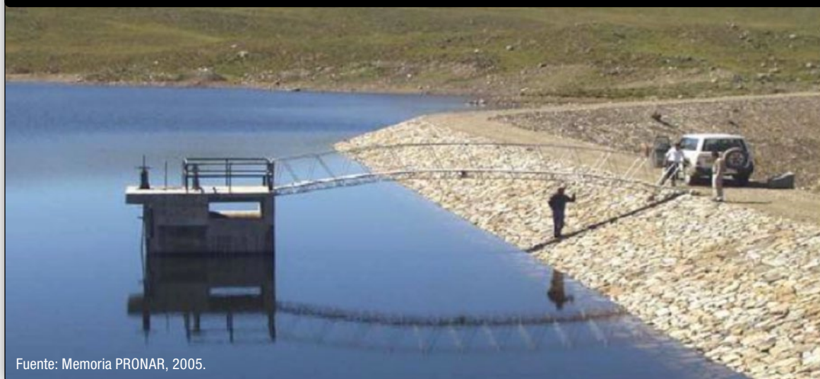
Figura 13. Presa de tierra, Municipio de Tiquipaya-Cochabamba
