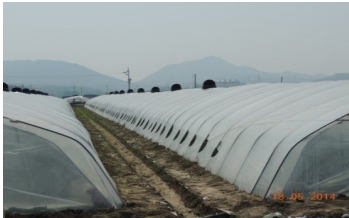
Figura 9. Macro túnel de hierro galvanizado
