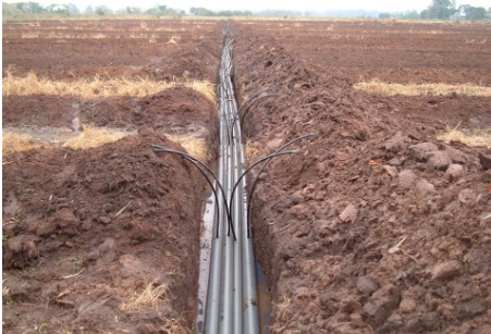
Tuberías secundarias bajo tierra
