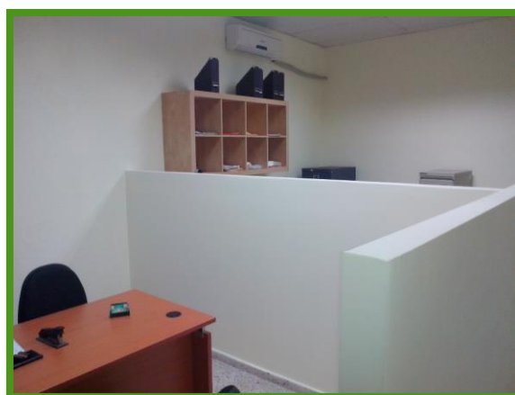
Remodelada y acondicionada la infraestructura del Laboratorio de Diagnóstico de la Estación de Pos-Entrada Vegetal.
