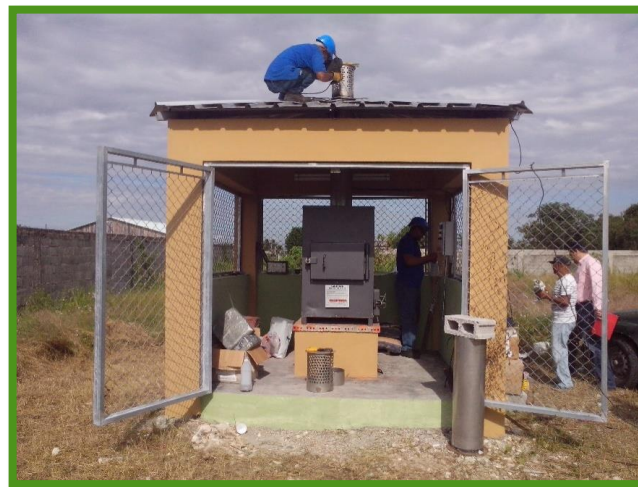
Caseta terminada e incinerador en proceso de instalación en la Estación de Cuarentena Vegetal.
