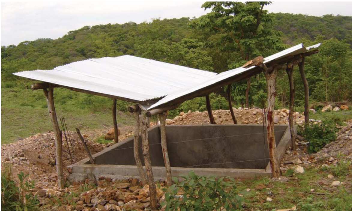
Estructura de captación de agua de lluvia construida en una de las zonas seleccionadas por el proyecto.
