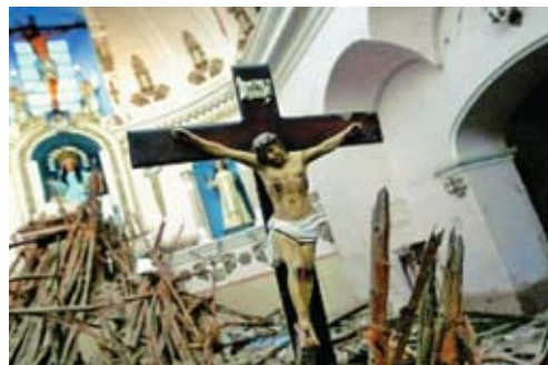
■ Imagen de la iglesia del Sr. de Luren, luego del terremoto
