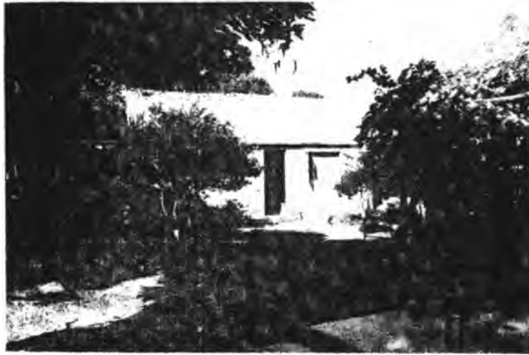
Figura No. 3 - Exterior de Vivienda de Nivel 3
