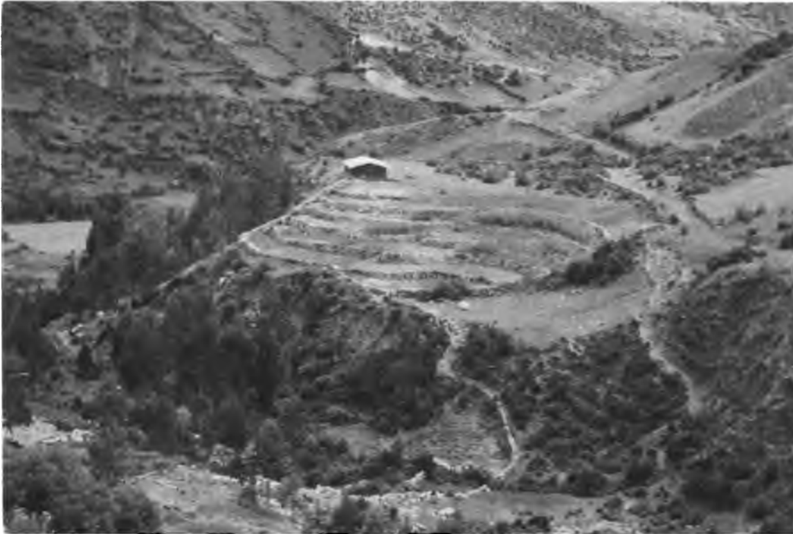
Vista de terrazas de absorción con talud de piedra, construido por el Club de Madres - Comunidad de Arizona.
