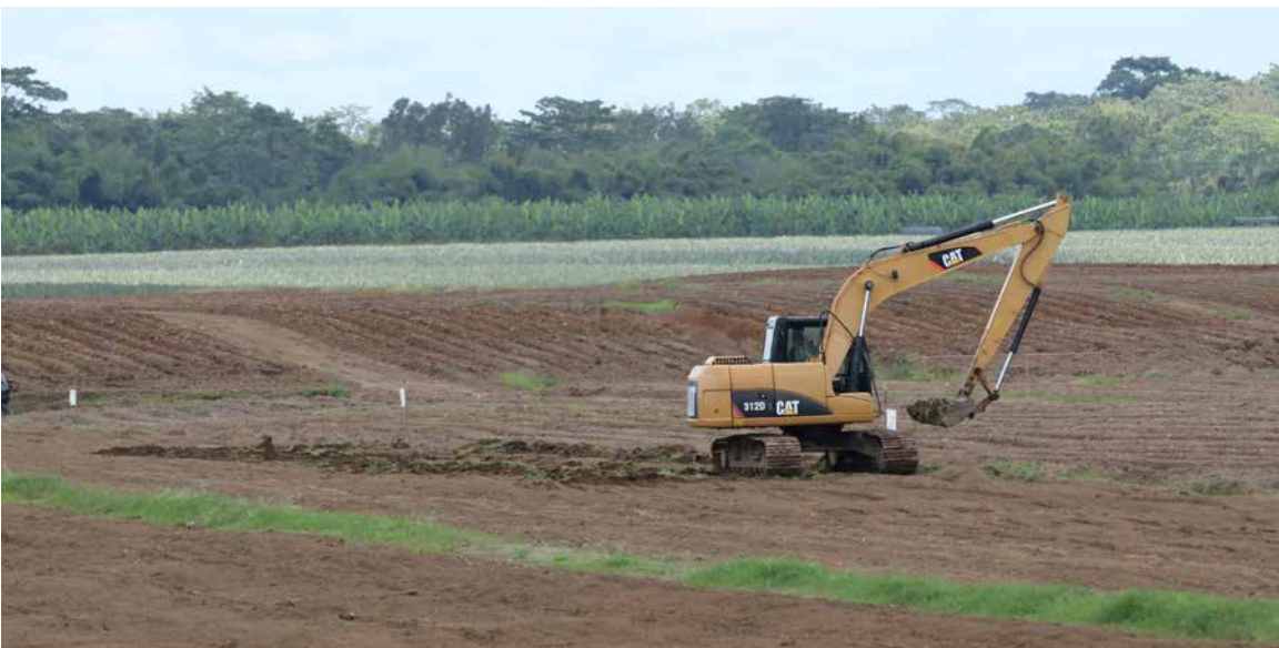
Construcción de canales de drenaje
