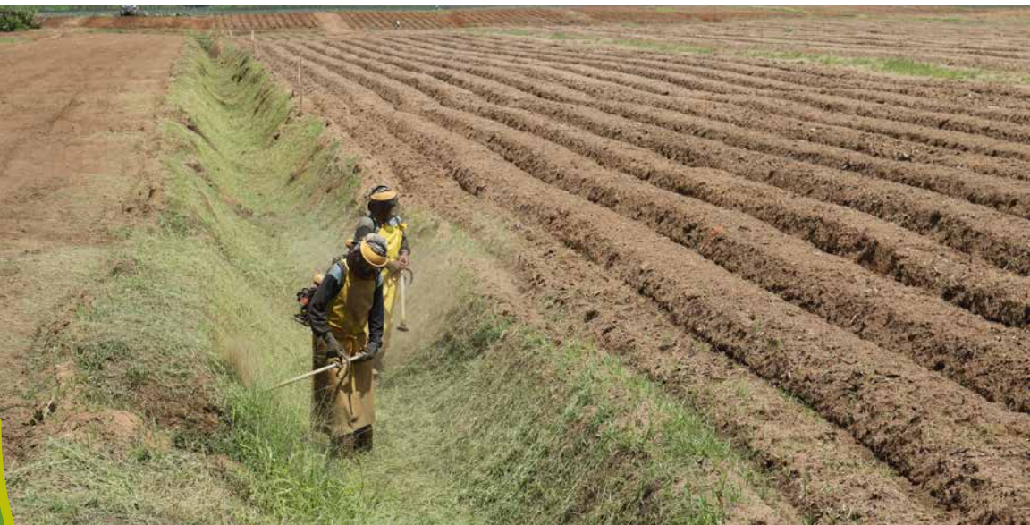
Mantenimiento de canales drenajes de forma mecánica
