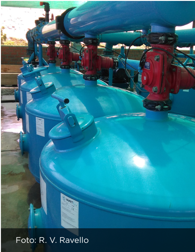
Ilustración 4. Sistema de filtrado: Filtro de grava.
