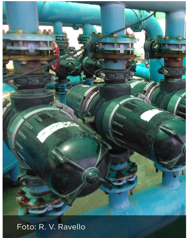
Ilustración 5. Sistema de filtrado: Filtro de anillos.
