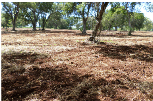
Preparación de terreno dejando árboles existentes H.B
