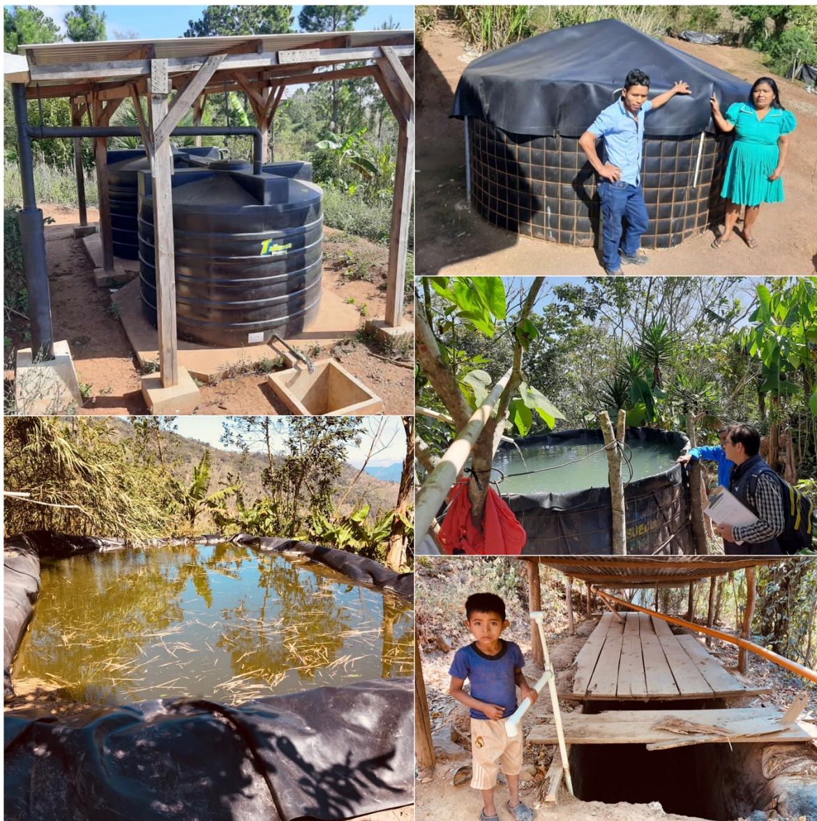
Figura 11. Sistemas de captación de agua de lluvia, establecidos en las comunidades de La Mina, Jocotán, Pintahaya, Camotán.
