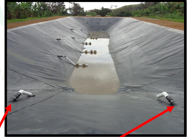
Tuberías de alimentación
