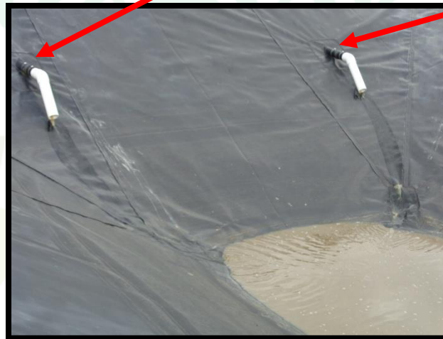
Tuberías de alimentación
