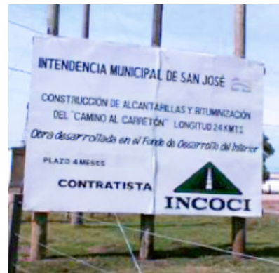
Camino al Carretón, San José
