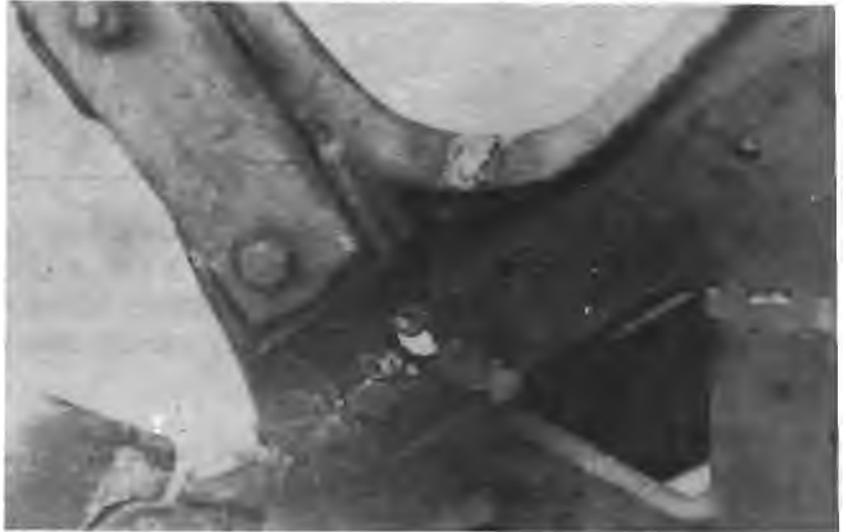
Foto 1. Detalle de la cureña o pieza central del arado reversible convencional. Observense las fracturas en la fundición.
