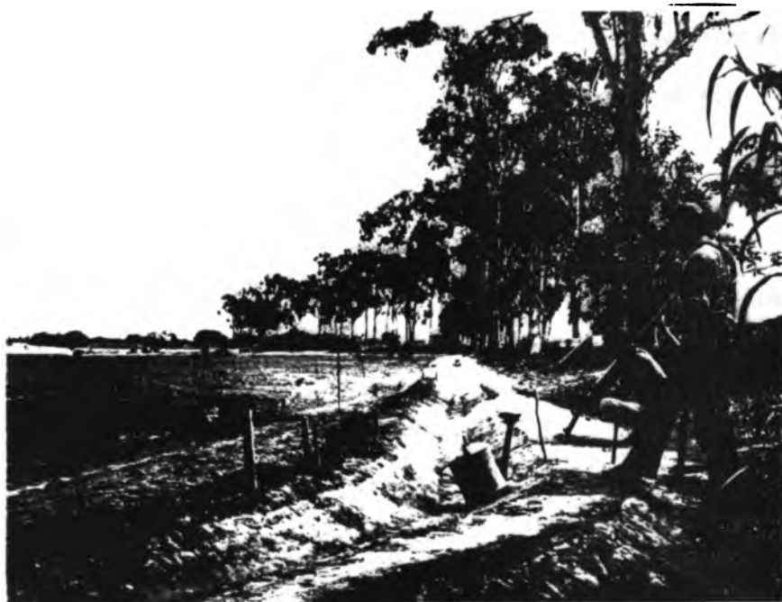
Alguns aspectos da construção dos canais de terra
