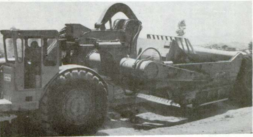
Fig. 108. Carga, transporte y descarga por la contracción y levantamiento de las paredes, en un nivelador/transportador de suelo (mototraílla).
