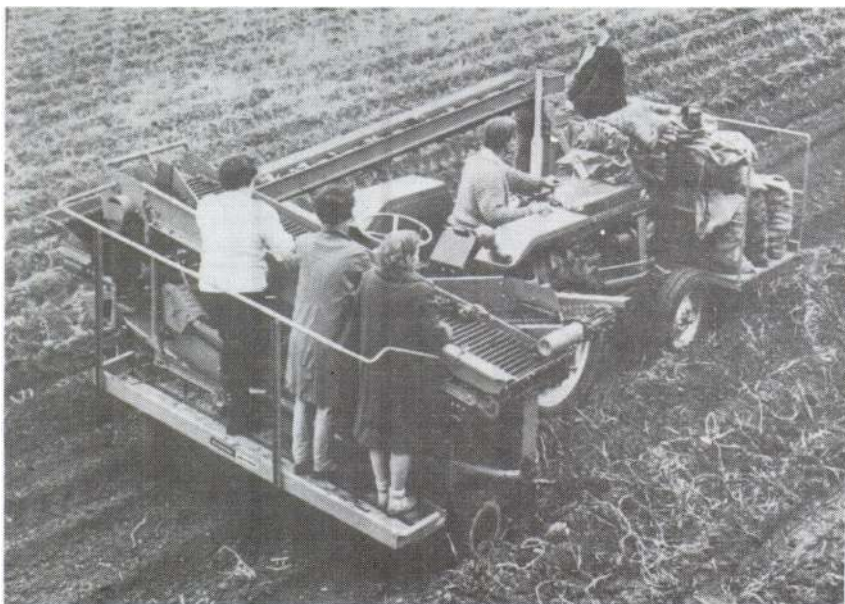
Fig. 252. Una herramienta que permite la cosecha de una hilera de papas, su selección a mano y finalmente su introducción en costales ( Ransomes, Sims and Jefferies, Ltd ).
