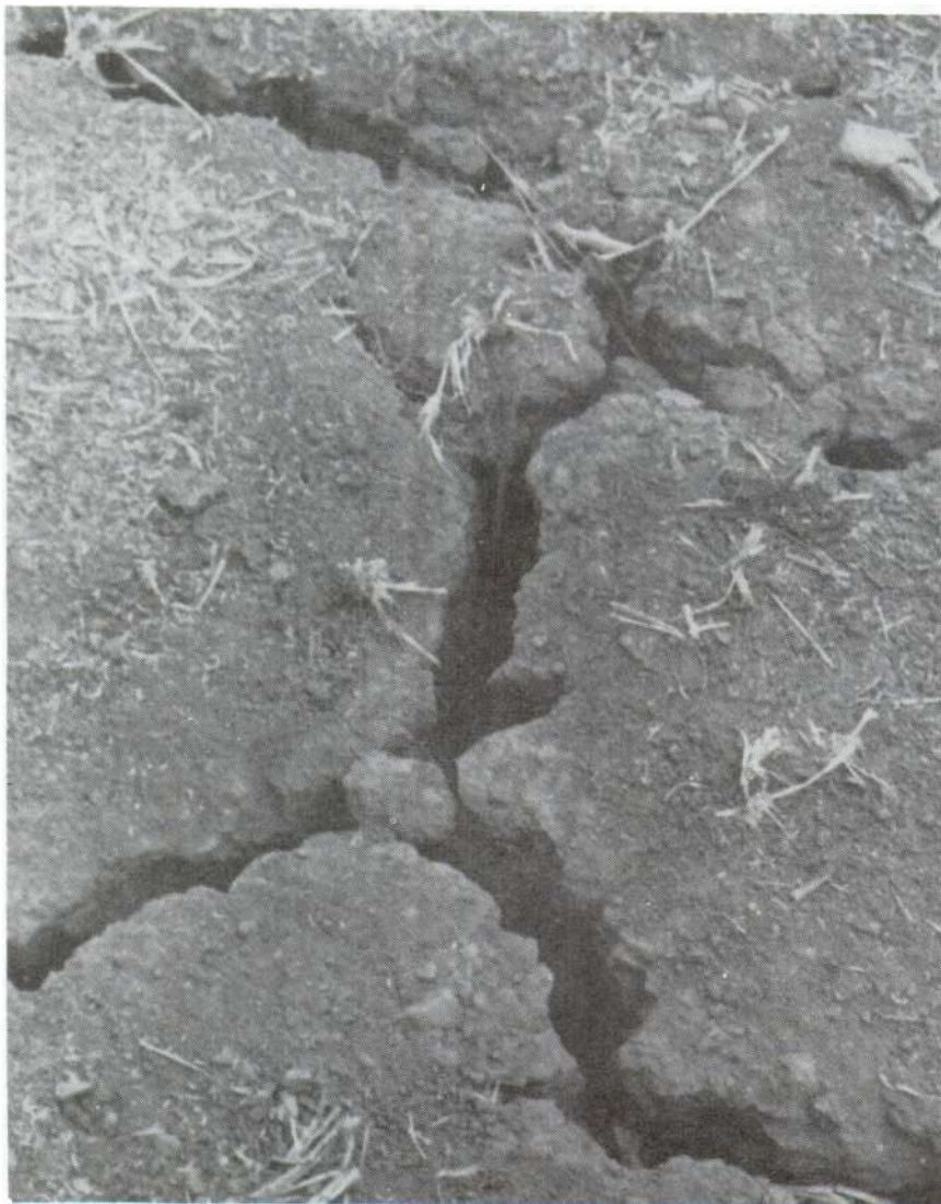
Fig. 127. Grietas de tensión profundas debido al secamiento y contracción de un suelo arcilloso (véase también la Fig. 122).
