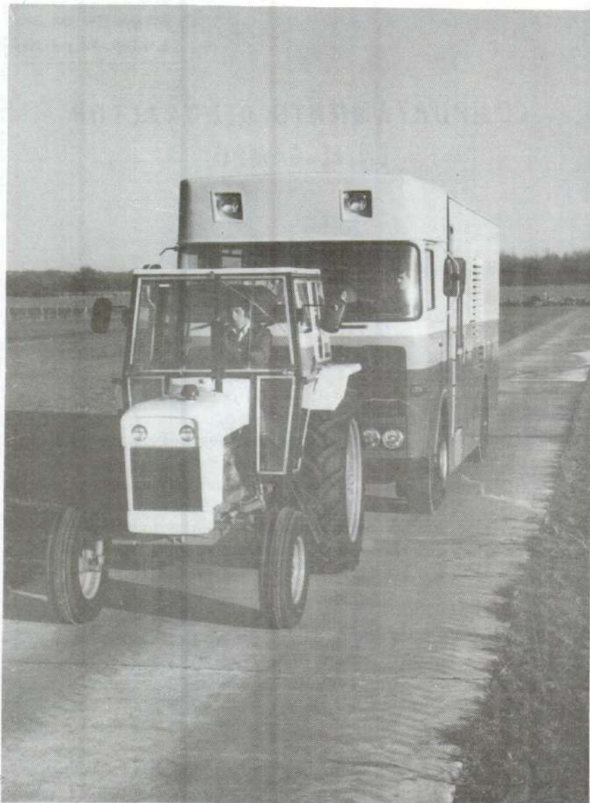
Fig. 238. Realización de una prueba de fuerza y potencia en la barra de tiro, sobre una pista especial. El vehículo de carga lleva instrumentos para grabar en forma continua la información (NIAE, Silsoe, Bedford, RU).
